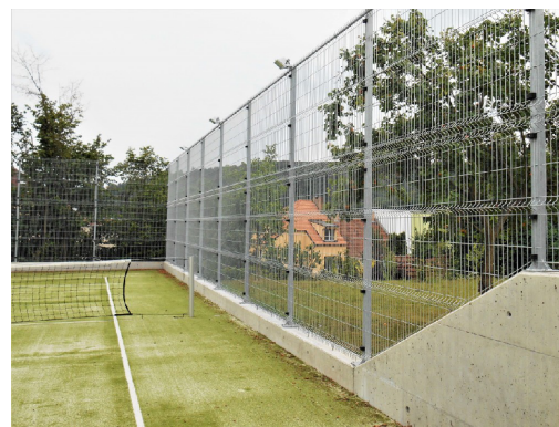
europlochy v modulu 2,5 výšky 4m ukotveno na pozinkované jaekly 100x100 kotvené do obvodové zidky
