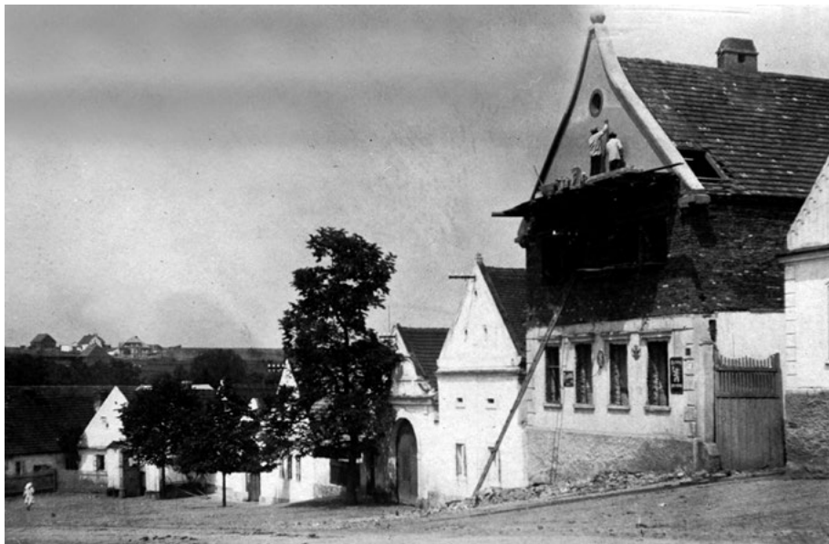
Stavba trojúhelného štítu na sokolovně
