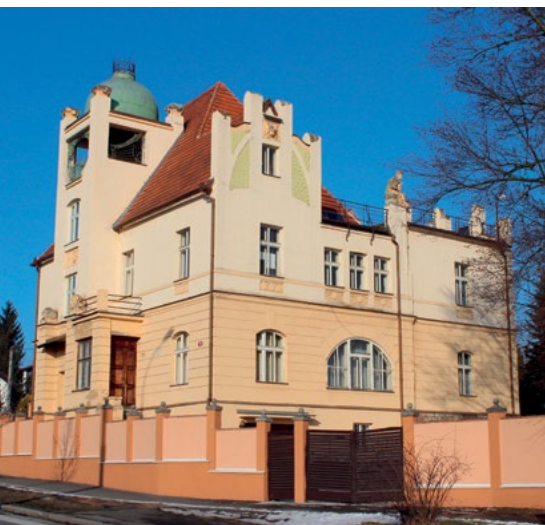
Secesní vila Karla Kestřánka v Karlovarské ulici v Plzni
