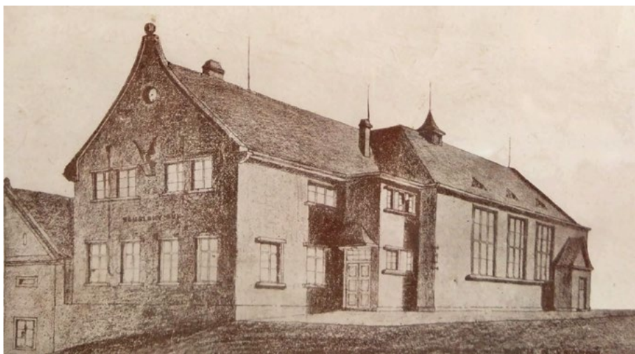
Vzhled dvorního průčelí, které se v téměř stejné podobě zachovalo dodnes. Místo vstupu vzadu je rozšířená zeď, postavená při přístavbě za sokolovnou.
