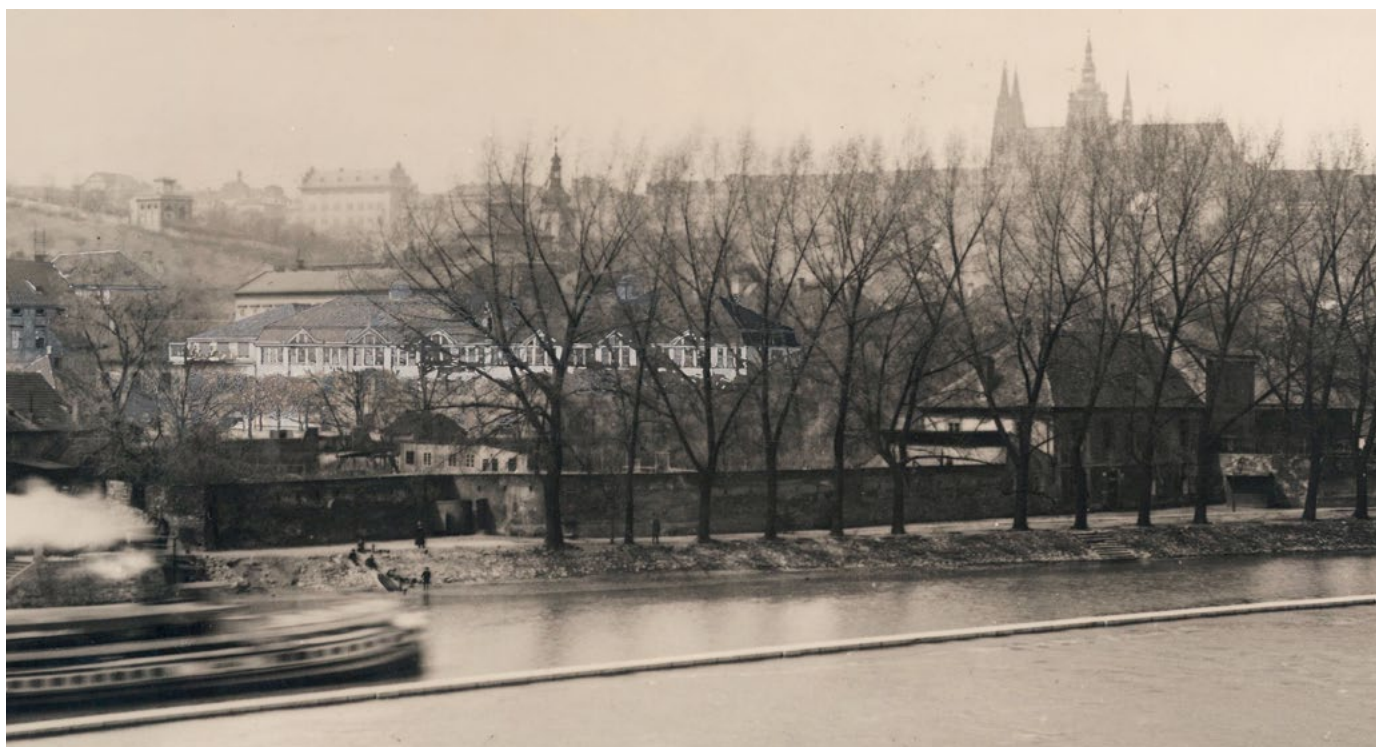
Soutěžní návrh na přestavbu Tyršova domu s heslem „Po 300 letech“
